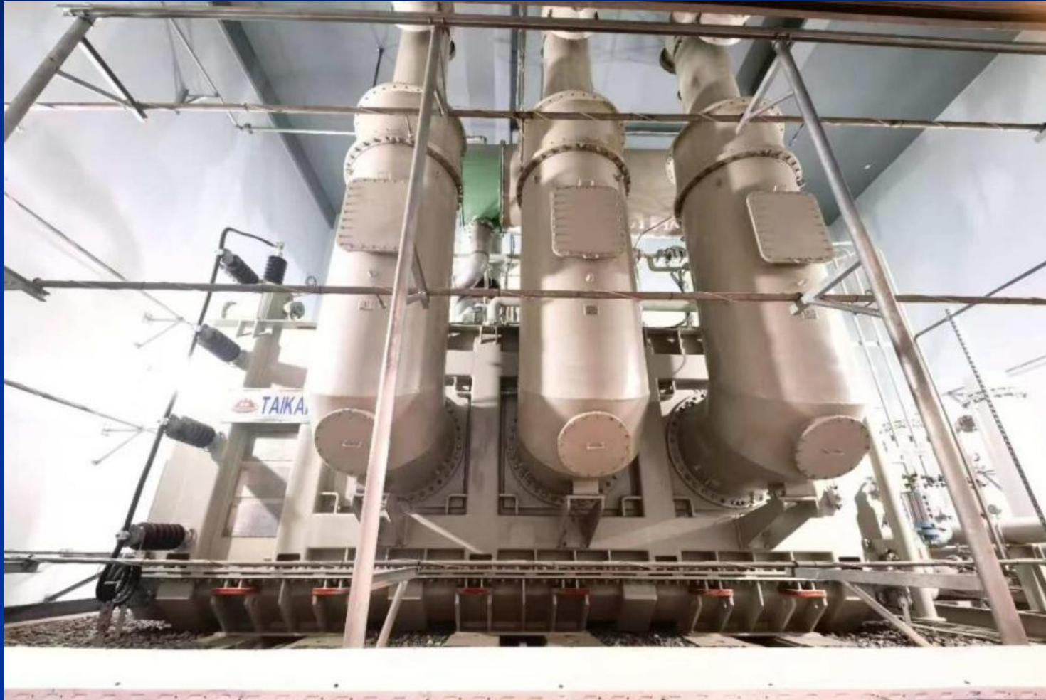
Transformador trifásico de circulación forzada de aceite de 400 kV y 123 MVA
